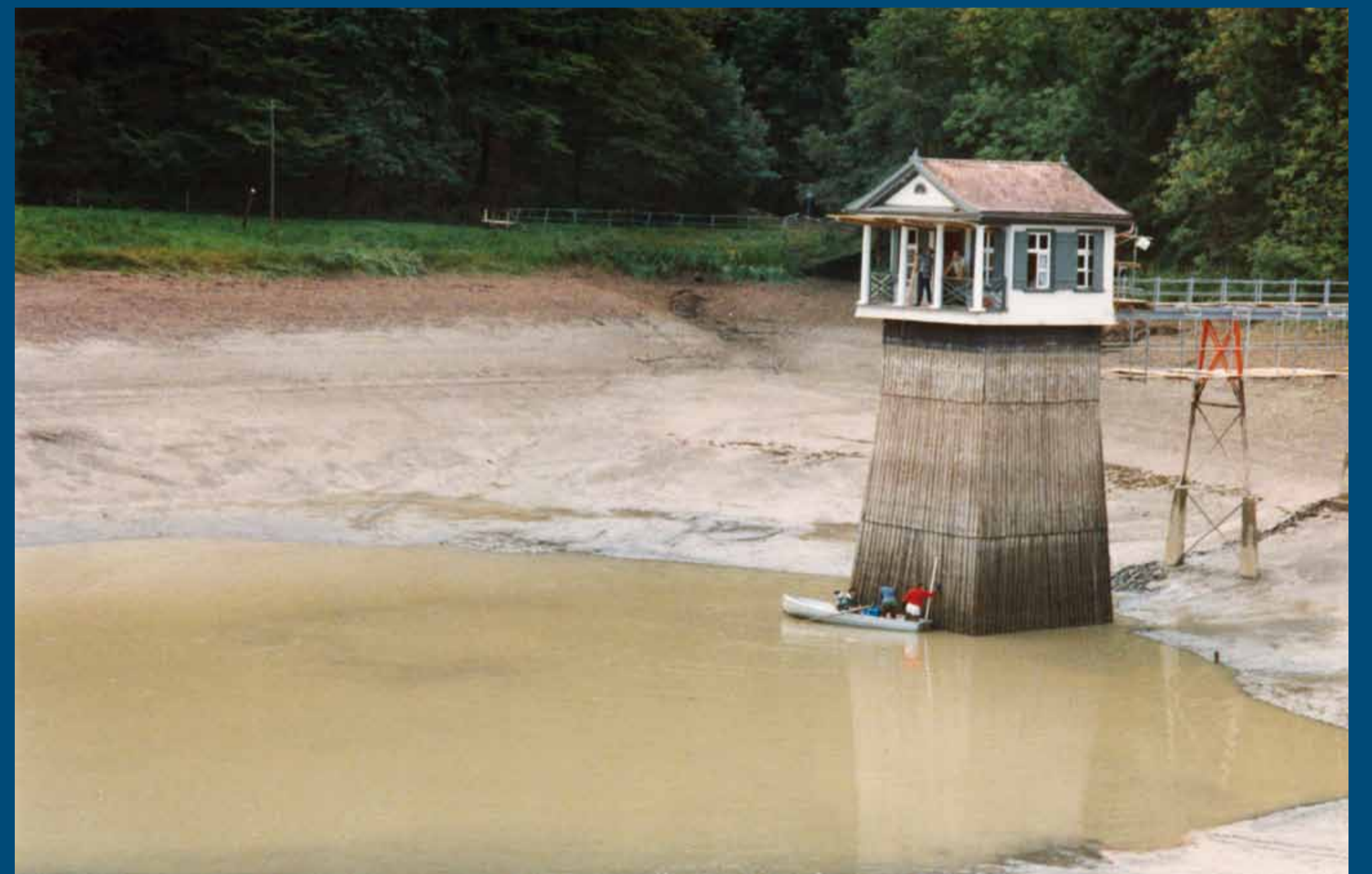
Die Metall-Holzkonstruktion, auf der das Schleusenhaus ruht, wird bei abgesenktem Wasserstand sichtbar; 1990.
