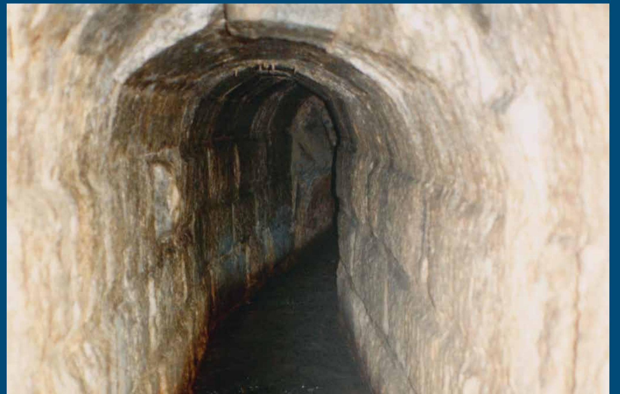
Grundablass-Stollen vom Wenigerweier in die Steinach; 1990.
