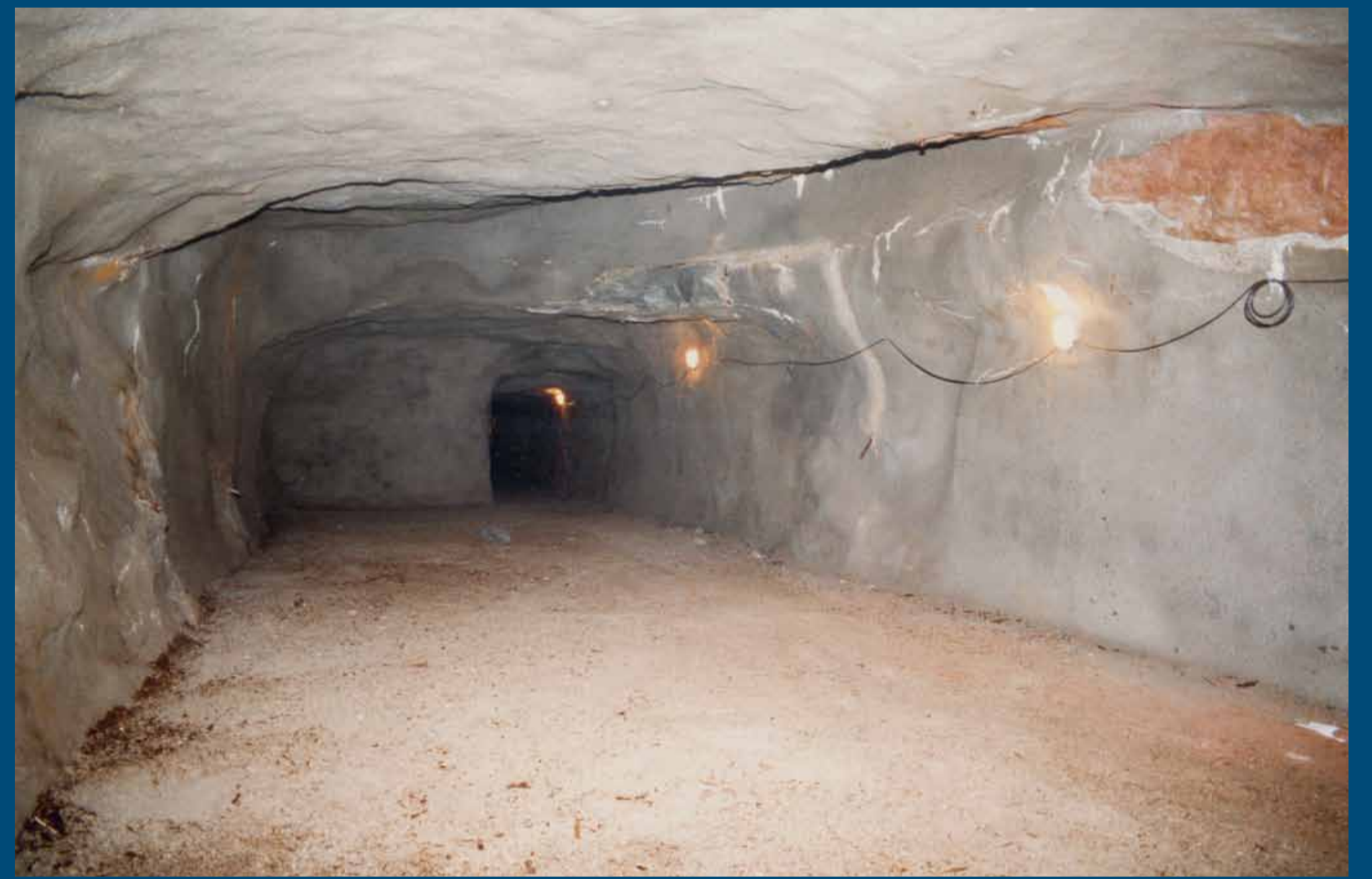
Blick in den Stollen. Hier war in den 1990er-Jahren ein «Kaffeebar-Raum» geplant.
