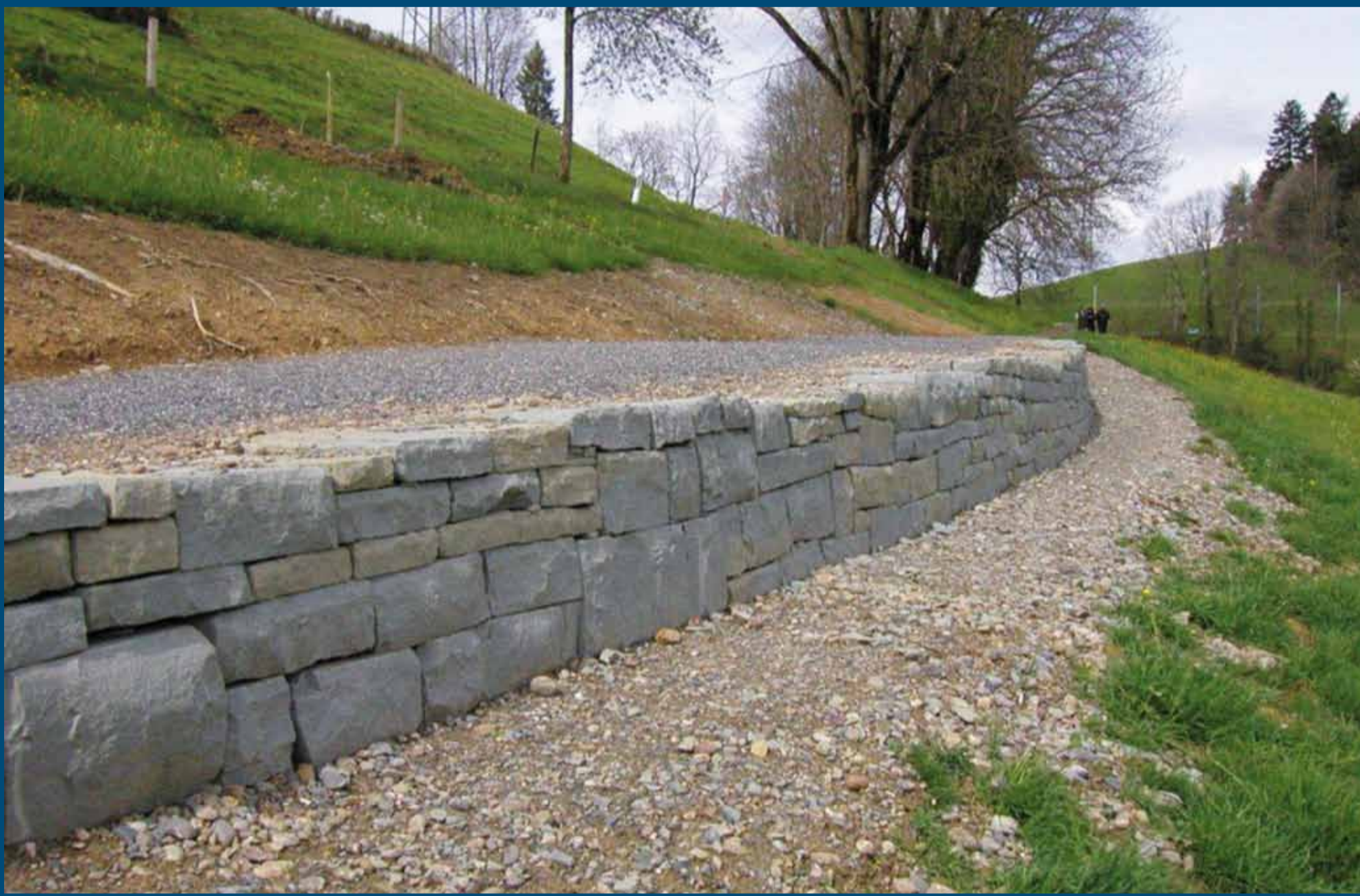
Trockenmauer, oben Fussweg, unten vorgelagerte Kiesfläche.
