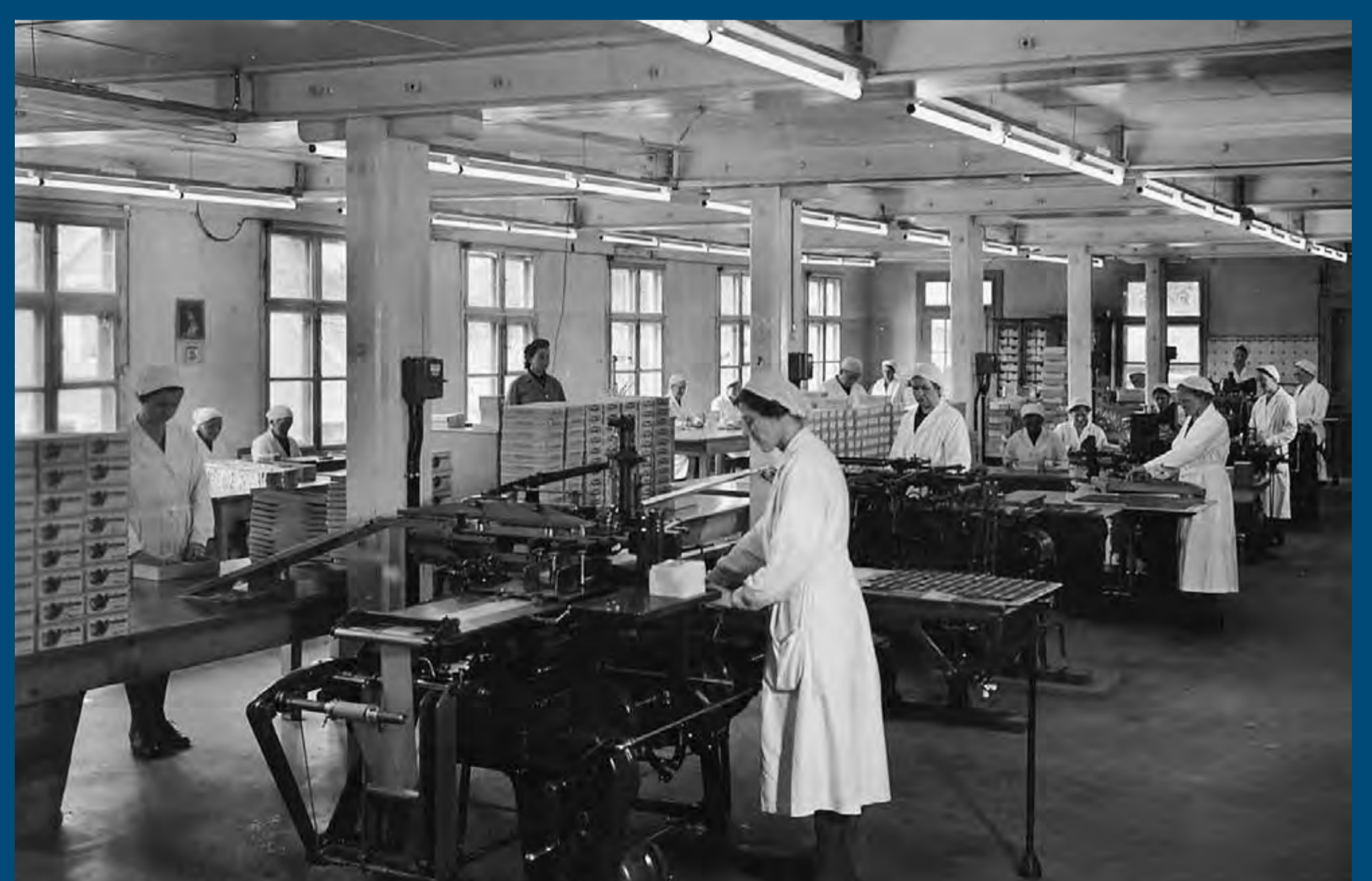
Produktionshalle der Schokoladefabrik Maestrani; um 1940.
