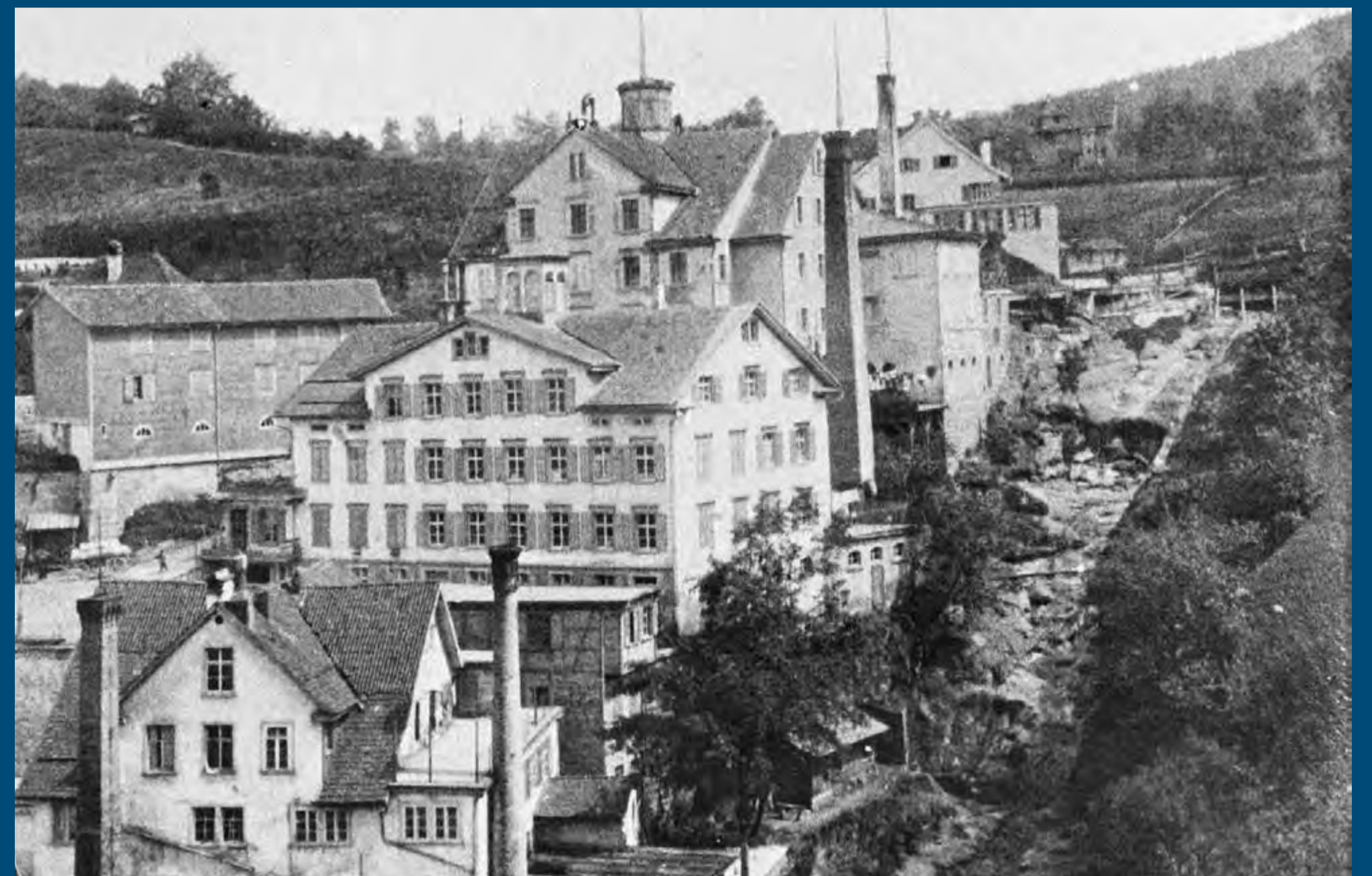
An die alten Gewerbebauten wurden bei der Einführung der Dampfkraft Hochkamine angebaut; 1889.
